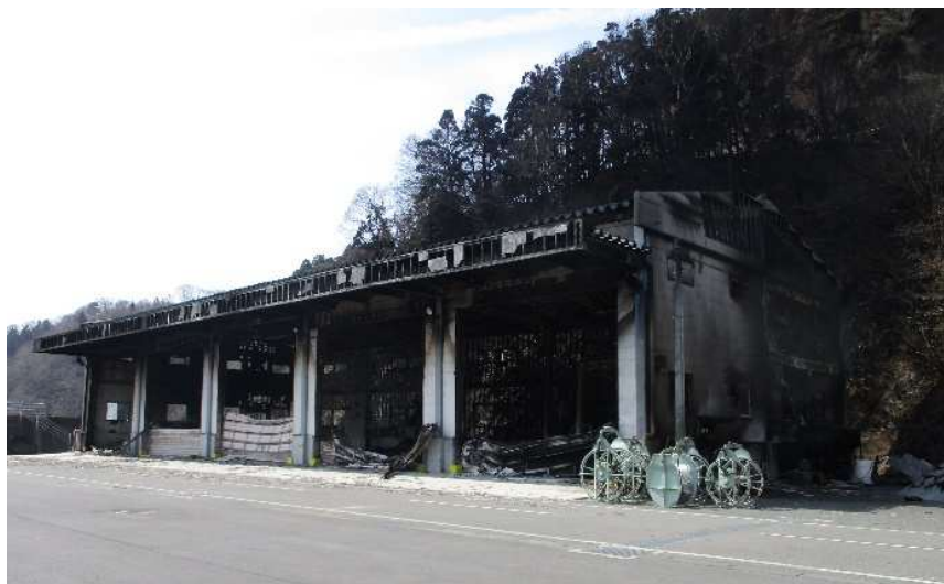
作業保管施設（定置漁業用倉庫）
