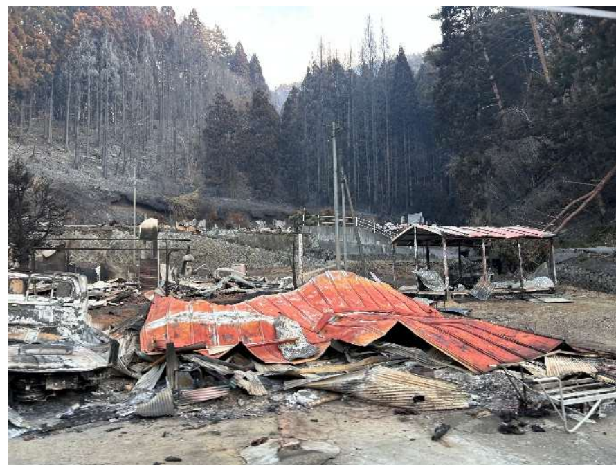
火災の被害を受けた家屋
