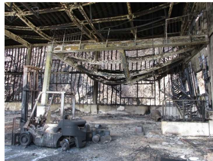
作業保管施設（定置漁業用倉庫）内部
