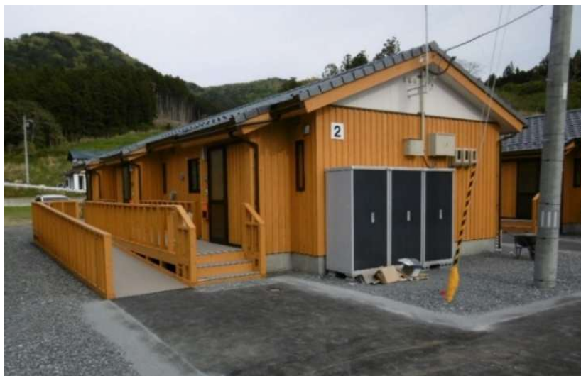
建設型応急仮設住宅(蛸ノ浦地区)
