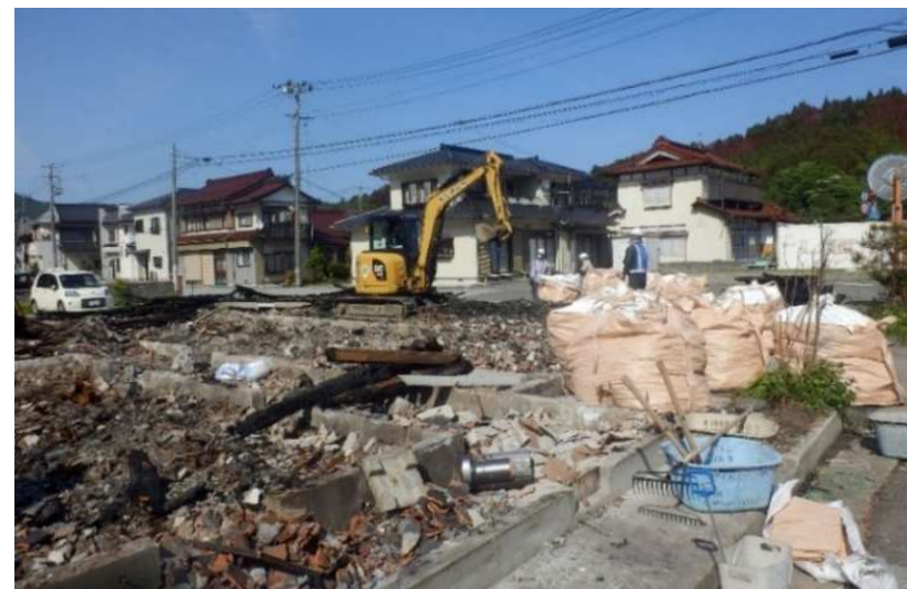
被災家屋等の公費解体
