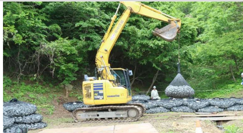
大型土のう設置
